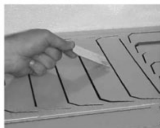
Sequenza apertura alette di diffusione
